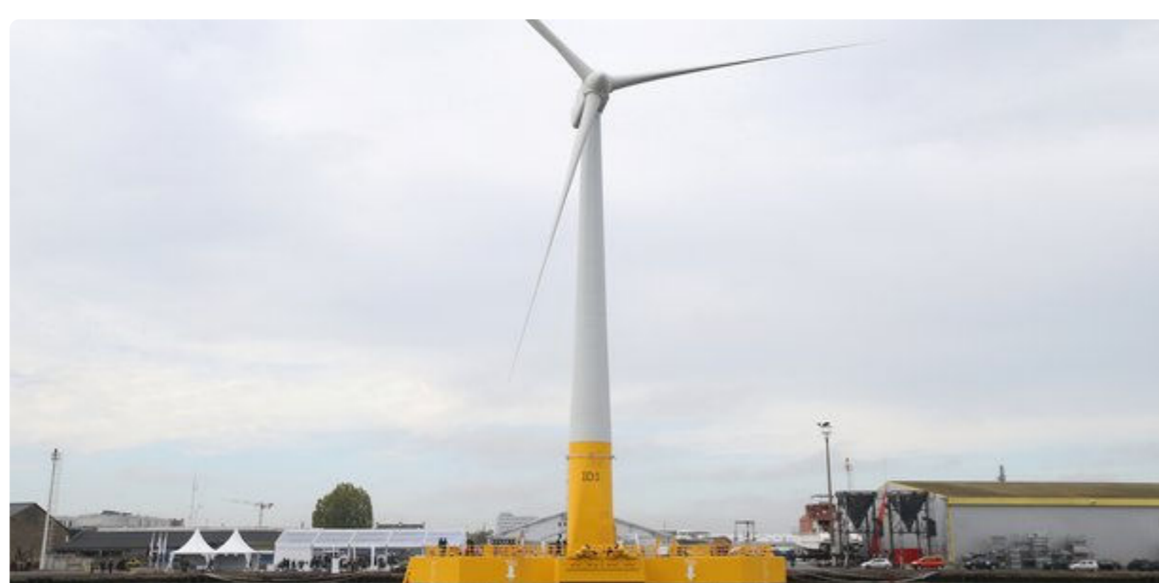
L'éolienne offshore dans le port de Saint-Nazaire.
